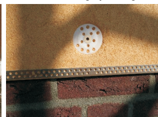
Start systeem met aluminium of rvs sokkelprofiel ca. 25 cm boven maai-veld; te voorzien van aanklikprofiel.
