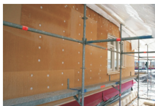
Bevestiging van Diffutherm-platen.
