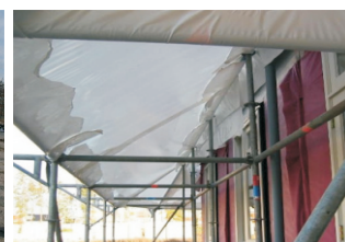
Kappen en netten op steigers tijdens montage en afwerking.
